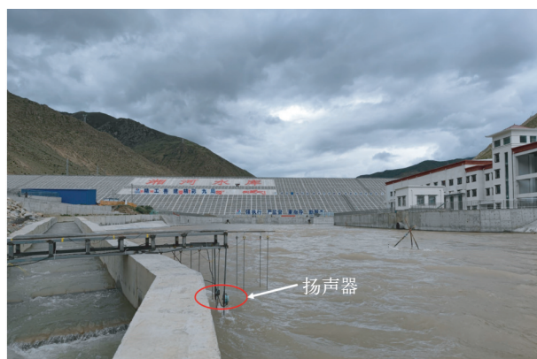
图3 湘河鱼道声驱鱼设施实拍图
