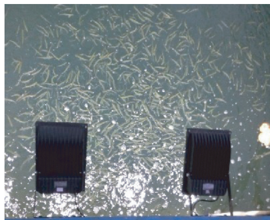
图4 马马崖一级水电站集运鱼系统光诱鱼设施实拍图
